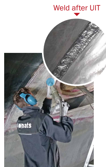
UIT on Aluminum weld
